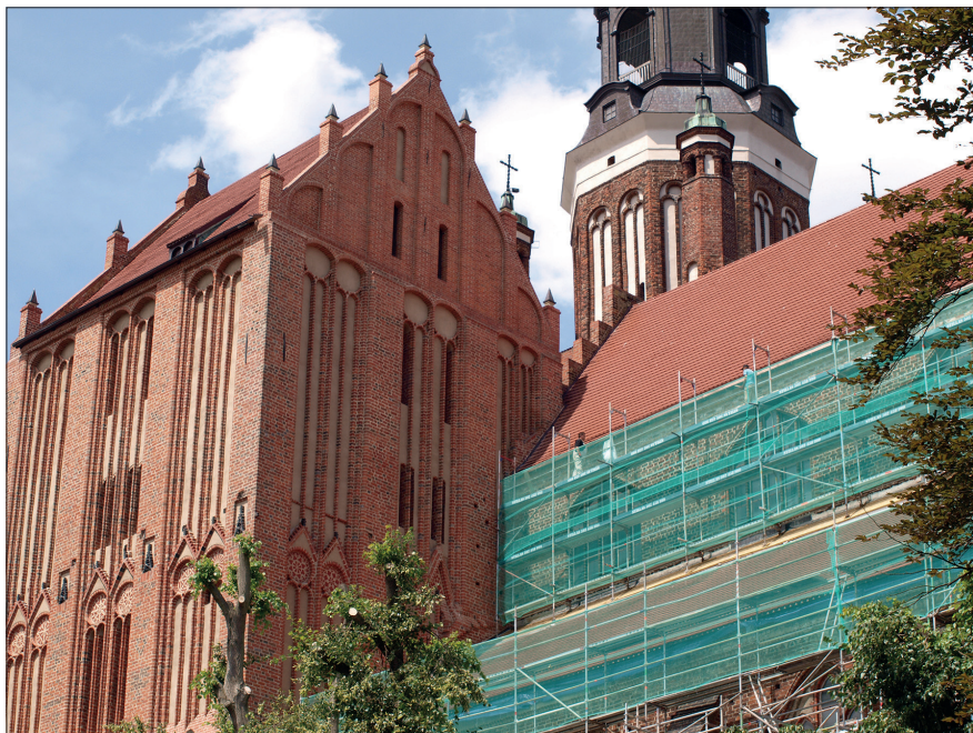
Ryc. 1. Prace renowacyjne Kościoła Mariackiego – wieża i elewacja południowa, wg stanu z 7 sierpnia 2018 r. Fot. A. Bierca MAH w Stargardzie
